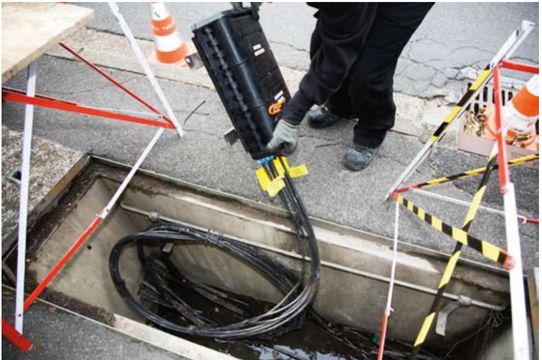
Fig. 4.1.11 Fibre connections in a street cabinet © François Maréchal for France Télécom Orange
